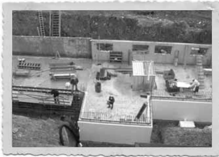
Mitarbeiter-Haus, Errichtung eines Kinderspielzimmers mit kleiner Lobby und Internet-Corner, Juni bis November 2007
